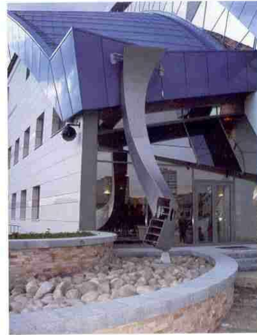
Merkwürdig verdrehte, überdimensionierte Fallrohre aus Edelstahl entwässern das Aluminiumdach in Azurblau-metallic.
